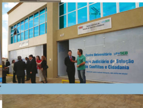
Fachada do CEJUSC
