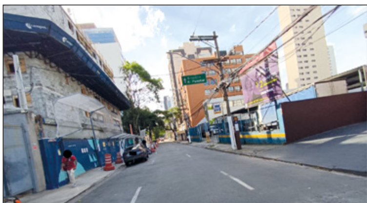
Figura 25 – Vistas próximas ao cruzamento da Rua Gomes de Carvalho com a Rua Ribeirão Claro, sentido Rua Nova Cidade.
