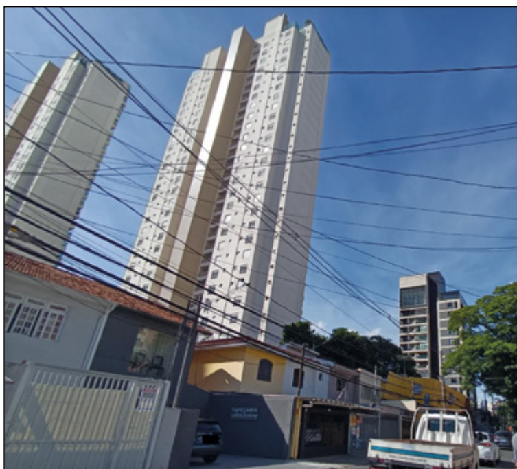
Figura 19 – Vista da quadra 104 a partir da Rua Ribeirão Claro. Note-se edificações conjugadas (sobrados geminados).
